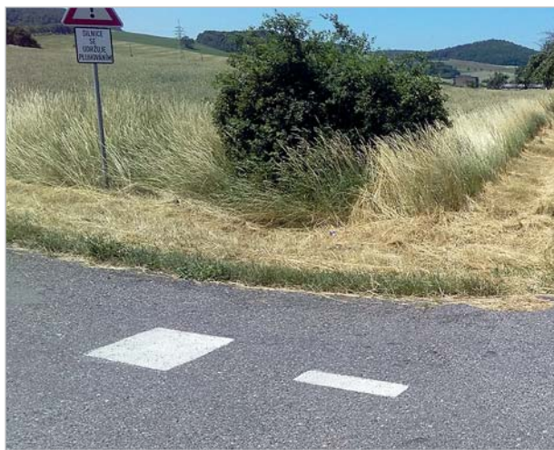
Obr. 3 Signalizace zajišťovacího bodu nátěrem na vedlejší komunikaci
