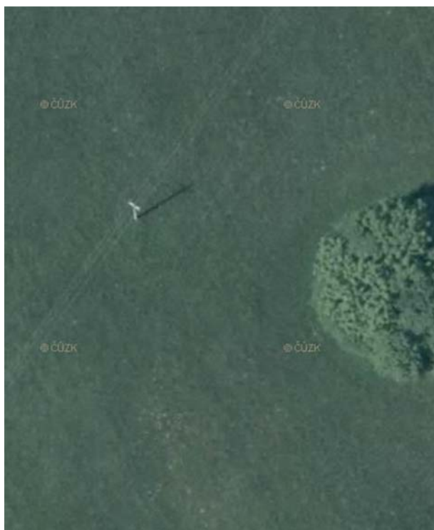
Obr. 5b Jednoduchý sloup vedení VN na Ortofotu ČR
