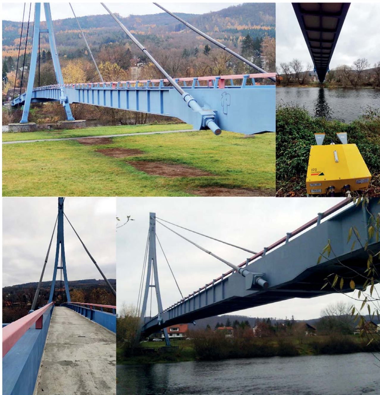
Obr. 3 Lávka přes řeku Berounku v Dobřichovicích s radary umístěnými pod lávkou
