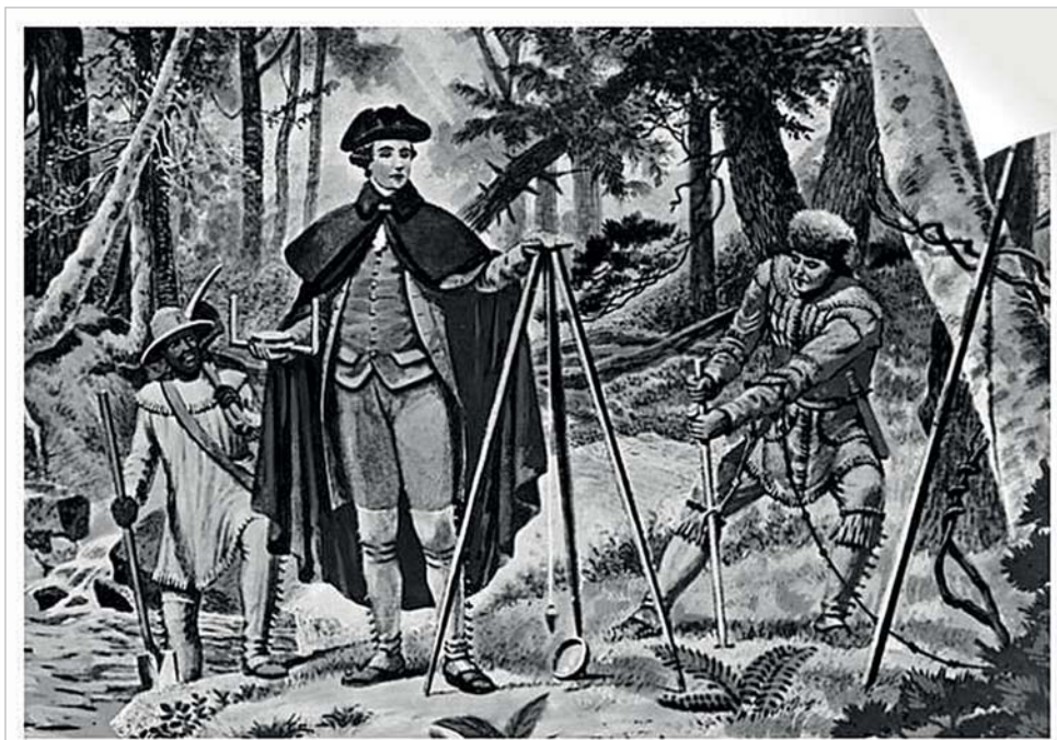
Obr. 6 George Washington s pomocníky, buzolou s průzory a měřickým řetězcem
