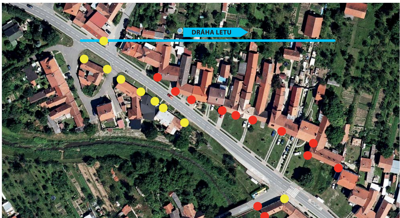
Obr. 6 KB (rohy domů) zakryté střešním pláštěm ● a identifikovatelné ● s ohledem na dráhu letu
