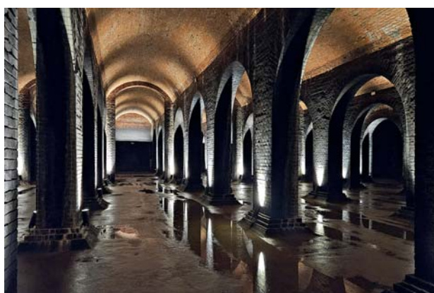
Obr. 5 Podzemné priestory pôvodných vodojemov
