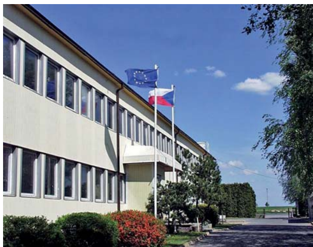
Obr. 1 První a současné sídlo VÚGTK
