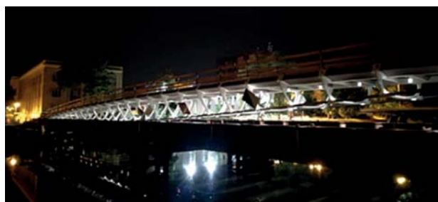
Obr. 19 Lávka v Hradci Králové s instalací měřicího systému VÚGTK
