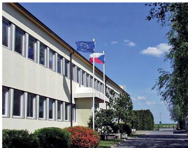
Obr. 1 První a současné sídlo VÚGTK
