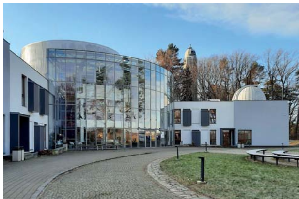
Budova Planetária Ostrava – súčasť HGF VŠB-TU Ostrava
