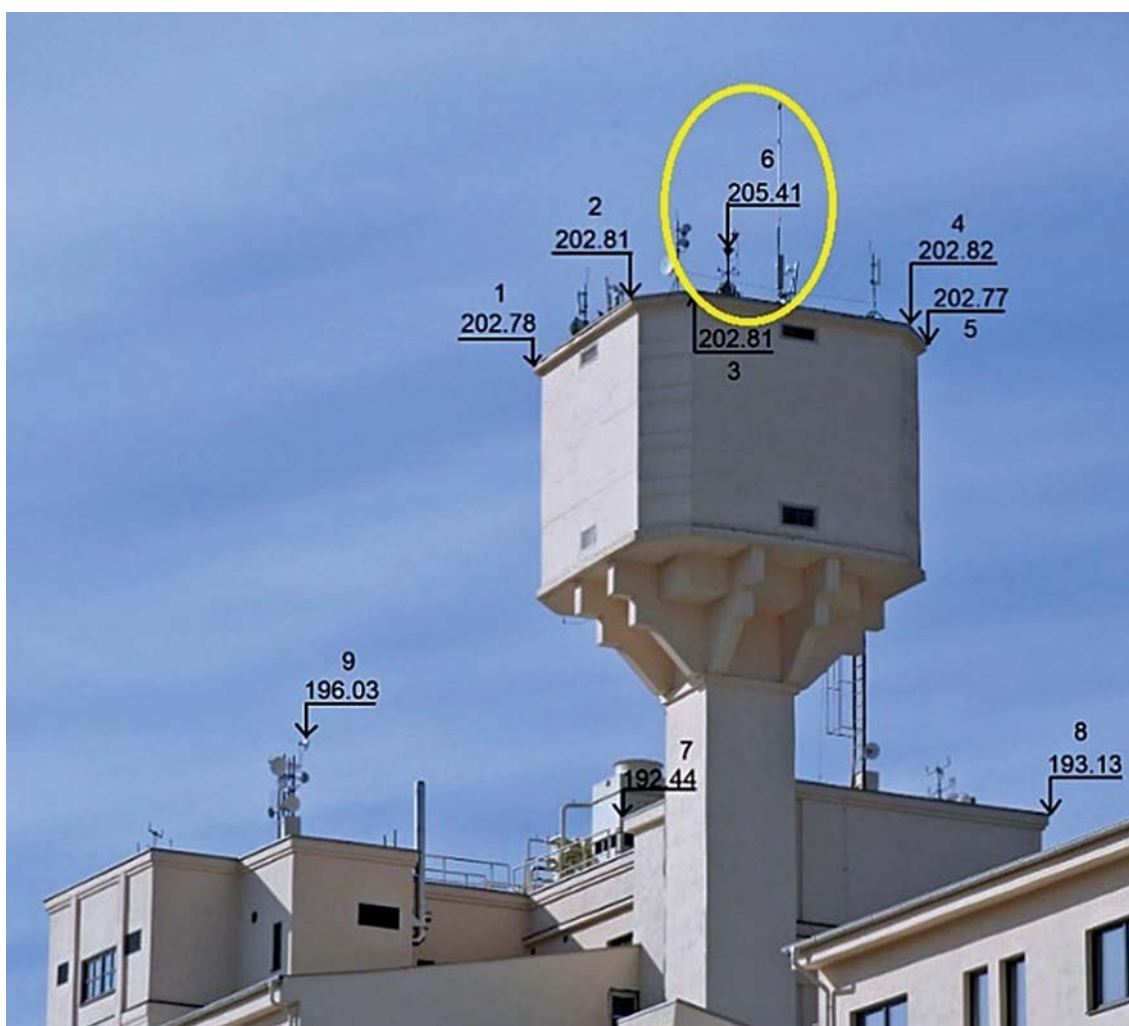
Obr. 14 Umiestnenia KB č. 6 na stavebnom objekte
