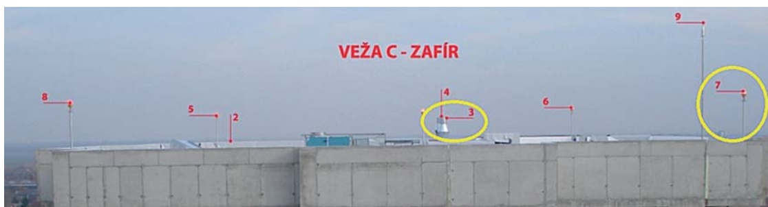
Obr. 19 Umiestnenia KB na stavebnom objekte
