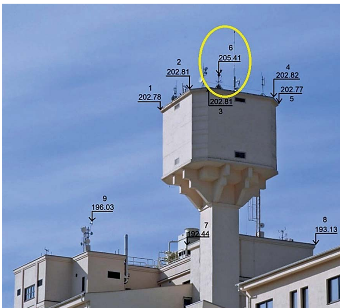
Obr. 14 Umiestnenia KB č. 6 na stavebnom objekte
