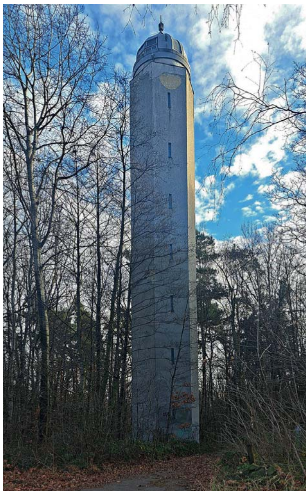
Obr. 10 Pylon u Planetária
