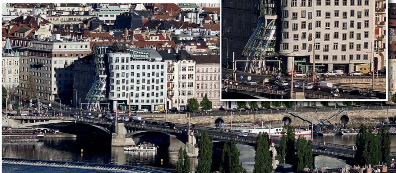
Obr. 1 Pohled z Petřína na vltavské nábřeží s detailem Tančícího domu
